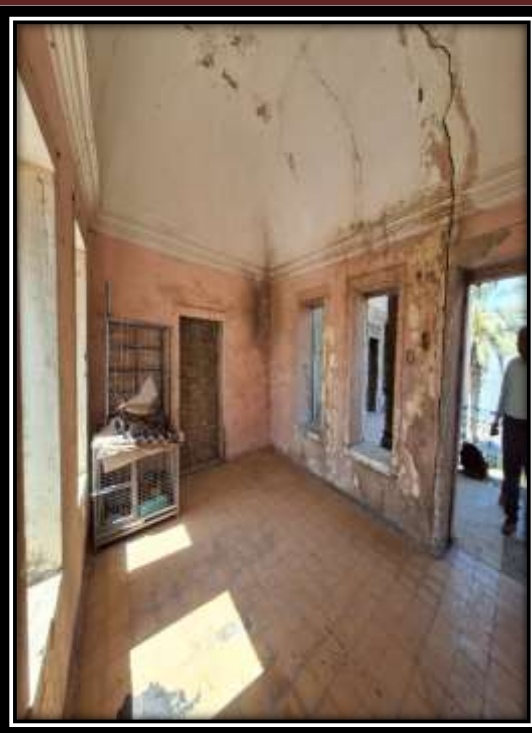
لوح رقم (١١) سقف الغرفة رقم ٤
