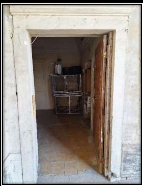
لوح رقم (٧) سقف الغرفة رقم ٢ قبو نصف أسطواني
