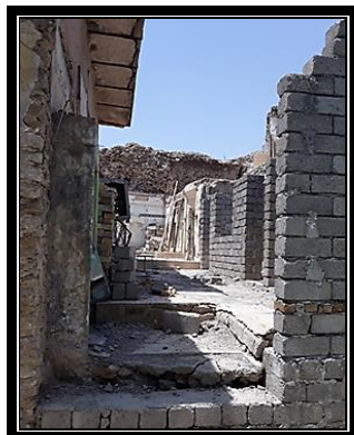
الصورة (٤٠) إعادة بناء القديم بمواد حديثة
