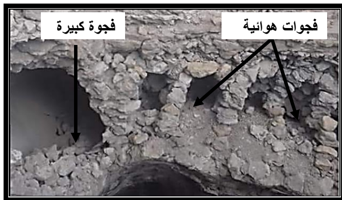
الصورة (٣٠) إحدى طرائق بناء سقوف مباني الموصل
