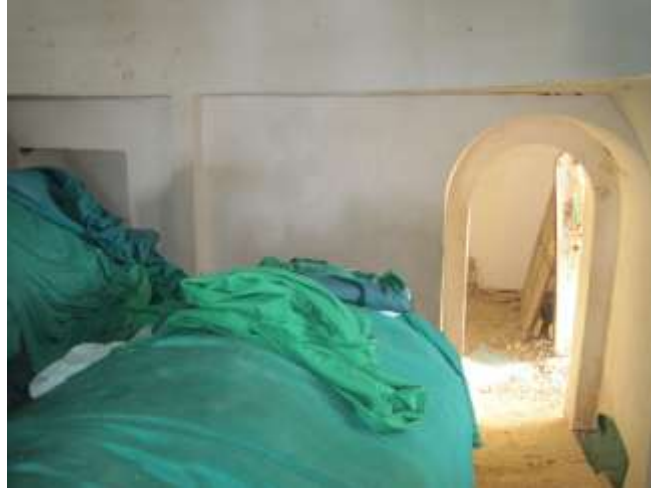
الصورة / ٧ منظر داخلي من القبة مع بوابتها الداخلية ونموذج الضريح (الباحثان)
