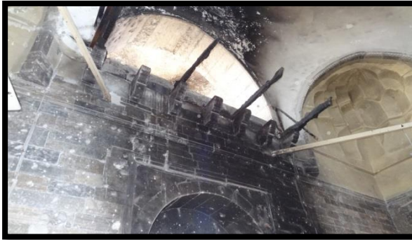
(صورة ١٣) شكل الكابول في جامع الاغوات الحاملة لمكان مصلى النساء (تصوير الباحث)
