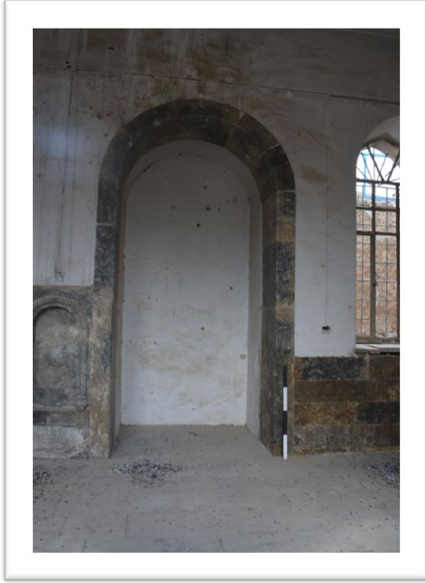
لوح رقم ( ٣٧ ) تجويف بالجدار يعلوه عقد نصف دائري وعلى يساره حنية رخامية
