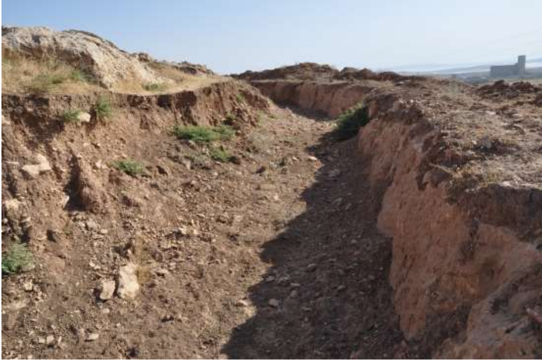
شكل (٩): قناة فايذة وتظهر ابعادها (العرض + العمق) الساعدة الجبلية الثانية - بعدسة الباحث -.
